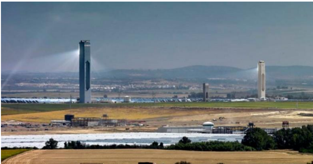
Planta solar de Abengoa en Sevilla. - Foto Efe.
