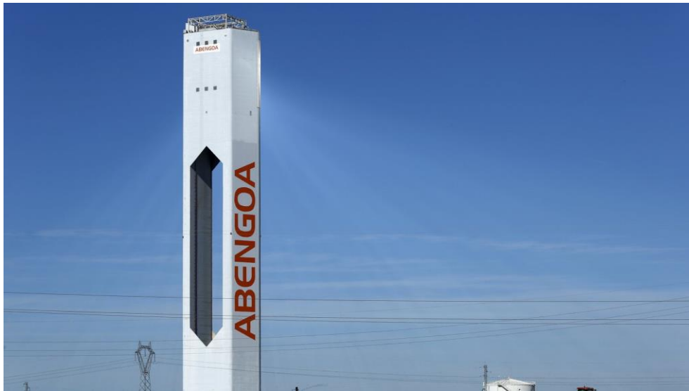
Parque solar de Abengoa en Sanlúcar la Mayor. Marcelo del Pozo Reuters
